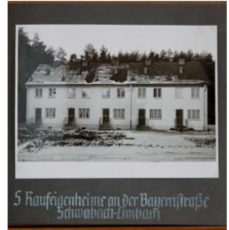
Das erste eigene Bauprojekt der Gewobau Schwabach: Kaufeigenheime in Schwabach-Limbach. Das Bild zeigt einen Ausschnitt aus einer Photomappe, die Oberbürgermeister Hans Hocheder 1960 zu seinem 65. Geburtstag als verdientem Gründer und Förderer der Gewobau Schwabach überreicht wurde.
