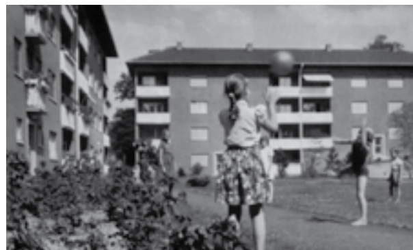
1930 noch ganz weit draußen vor der Stadt: die Reichenbacher Straße. Darunter eine Aufnahme der Wohnanlage Reichenbacher-/Grünwaldstraße etwa um das Jahr 1968.
