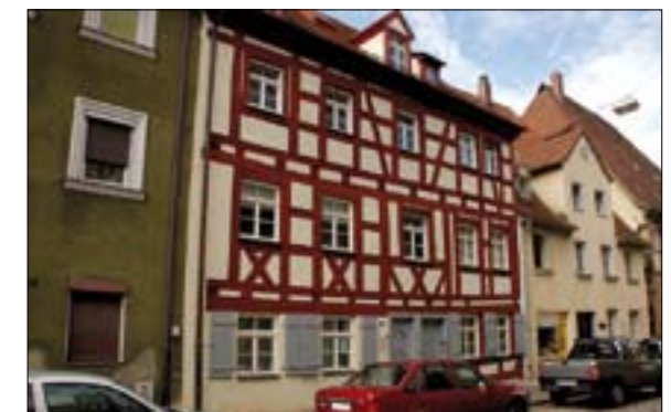
1987 das erste der Altstadtsanierungsobjekt für die Gewobau Schwabach: das Alte Spital hinter der Spitalkirche. Heute beherbergt es mehrere Wohnungen. Darunter ein 2003 saniertes Wohngebäude: die Friedrichstraße 25.
